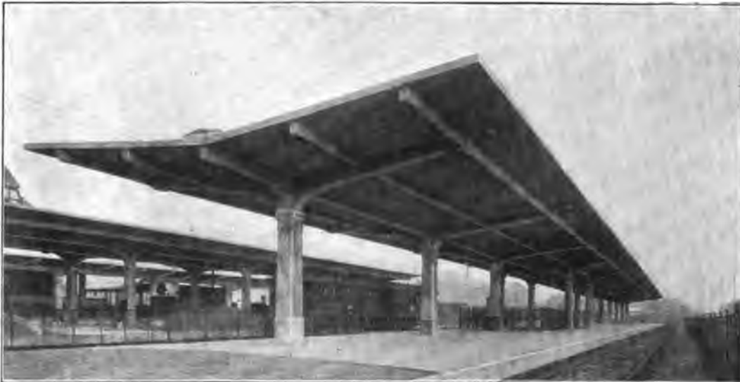
Abb. 94. Einstielige Bahnsteighalle in Sonneberg, Thüringen.
